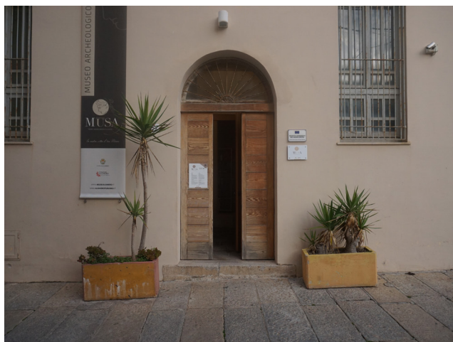
Figura 25. Entrata principale su via Carlo Alberto
